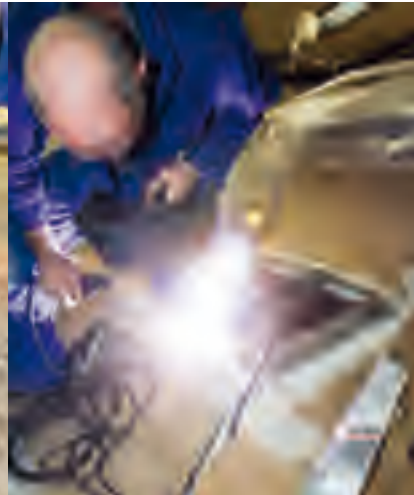
We lassen het luikhoofd vast. De directe omgeving is met karton beschermd tegen lasspetters. Ook moeten we de betimmering beschermen tegen oververhitting. Daarom lassen we korte tijd op een plek en gaan verder bij een ander deel.
