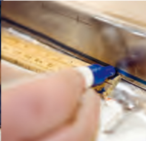
Als het luikhoofd gecentreerd en waterpas ligt, tekenen we dit af, met de dekronding mee - met een duimstok als hoogtegeleider. Zo krijgt het exact de vorm van het dak en zijn er geen kieren.
