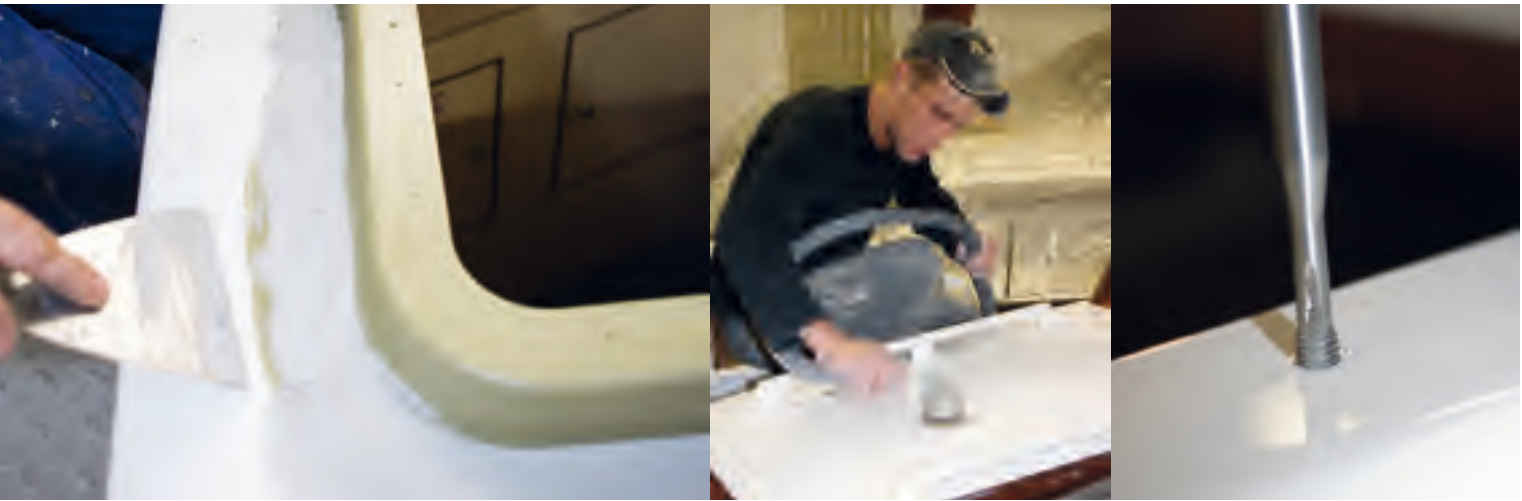
...geplamuurd met een fillet (een holle kwartrond overgang van het staande naar het liggende deel)...
