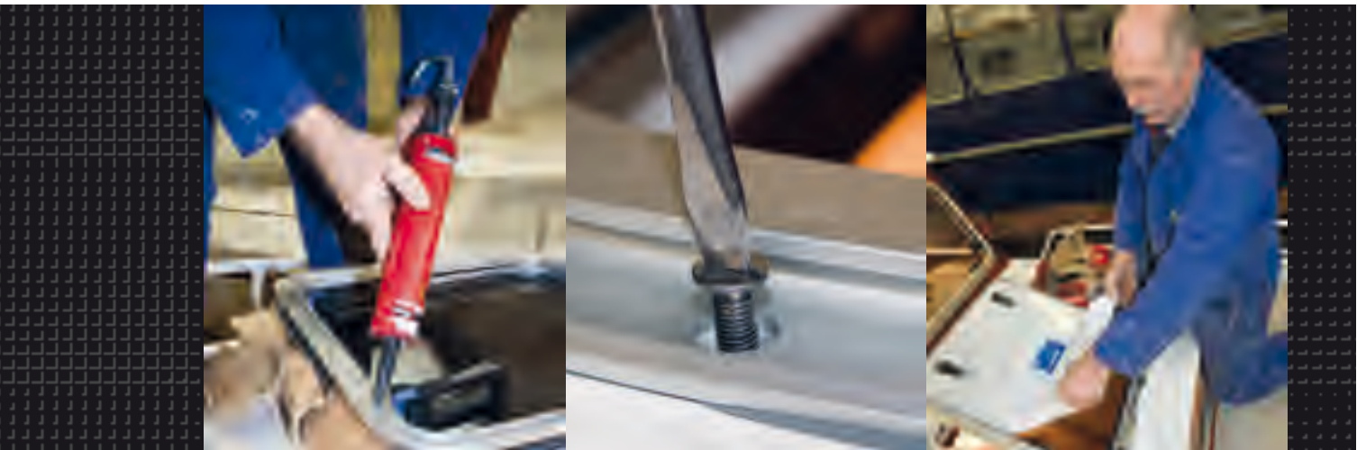
Het nieuwe voorluik ligt ondersteboven om de flens te kitten. Liever te veel kit dan te weinig; we willen geen risico op lekkage. Ook isoleert de kitlaag het aluminium van het roestvast stalen luikhoofd; dit voorkomt galvanische corrosie.
