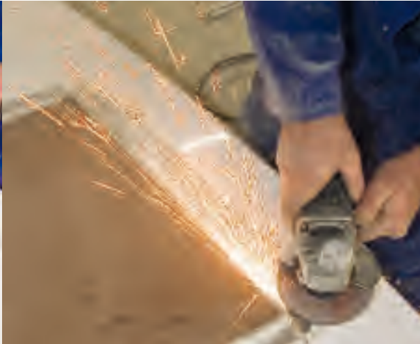
Voordat het luikhoofd kan worden vastgelast, moeten we het dak ter plekke kaal slijpen. Alle verf- en plamuurresten moeten verwijderd zijn. Het gat maken we dicht met een plaat triplex, om een vonkenregen in de voorhut te voorkomen.
